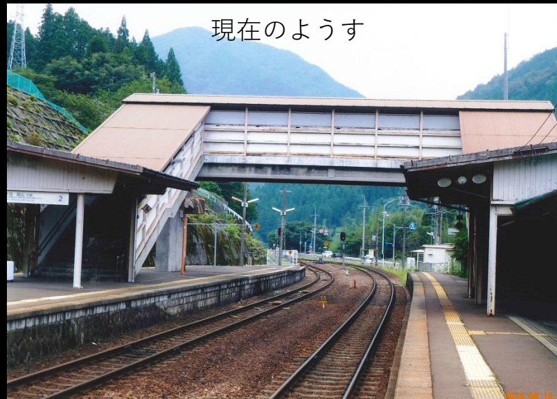
跨線橋工事 - 白川口駅 S39.9.5 - 林 茂男 (白川町河岐)
